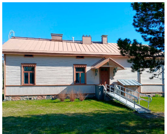
Suomenniemen kirjaston esteettömyyttä parannettiin rakentamalla takaovelle ramppi.
